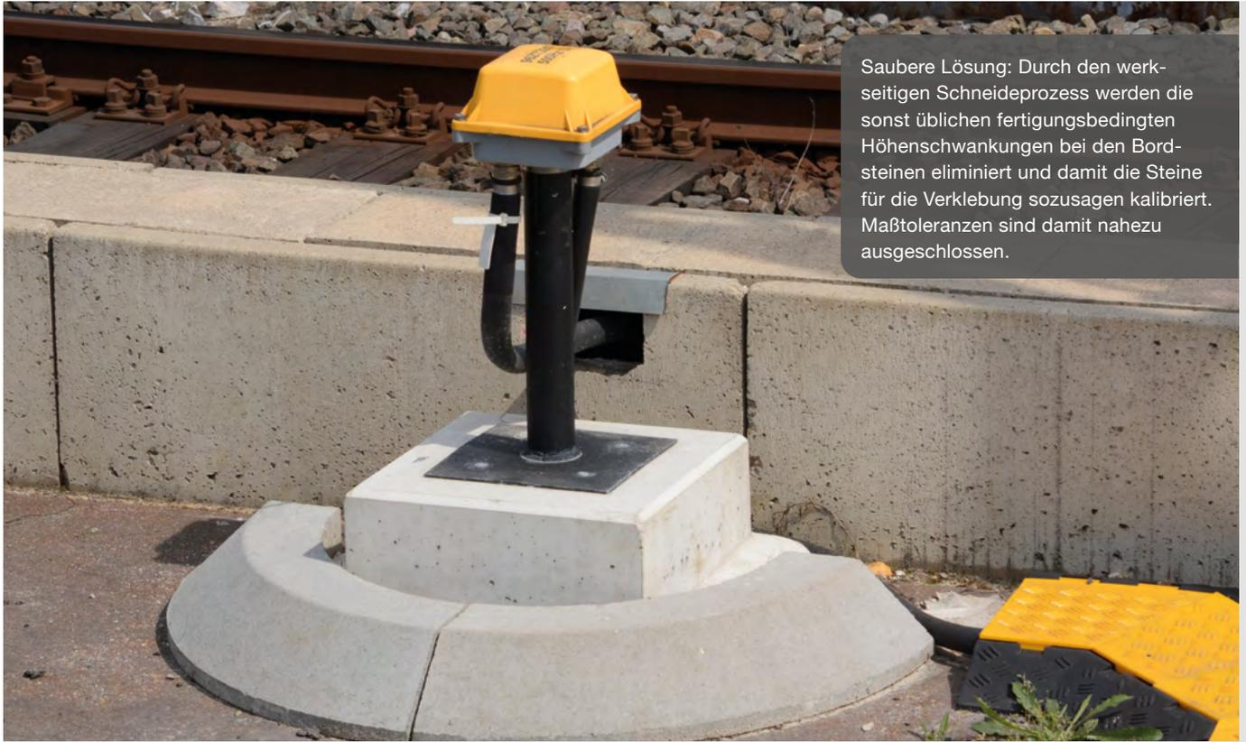
Saubere Lösung: Durch den werkseitigen Schneideprozess werden die sonst üblichen fertigungsbedingten Höhenschwankungen bei den Bordsteinen eliminiert und damit die Steine für die Verklebung sozusagen kalibriert. Maßtoleranzen sind damit nahezu ausgeschlossen.
