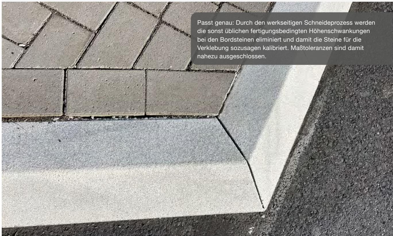
Passt genau: Durch den werkseitigen Schneideprozess werden die sonst üblichen fertigungsbedingten Höhenschwankungen bei den Bordsteinen eliminiert und damit die Steine für die Verklebung sozusagen kalibriert. Maßtoleranzen sind damit nahezu ausgeschlossen.
