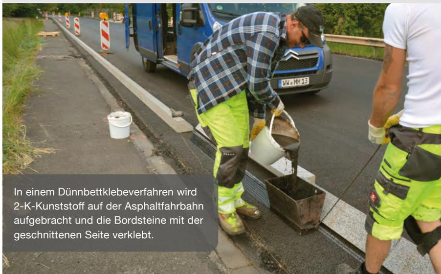
In einem Dünnbettklebverfahren wird 2-K-Kunststoff auf der Asphaltfahrbahn aufgebracht und die Bordsteine mit der geschnittenen Seite verklebt.
