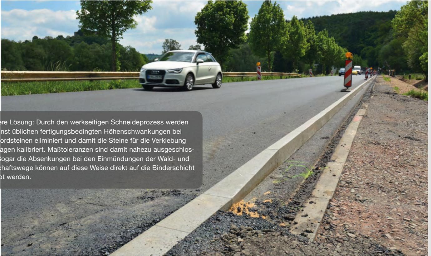
Saubere Lösung: Durch den werkseitigen Schneideprozess werden die sonst üblichen fertigungsbedingten Höhenschwankungen bei den Bordsteinen eliminiert und damit die Verklebung sozusagen kalibriert. Maßtoleranzen sind damit nahezu ausgeschlossen. Sogar die Absenkungen bei den Einmündungen der Wald- und Wirtschaftswege können auf diese Weise direkt auf die Binderschicht geklebt werden.
