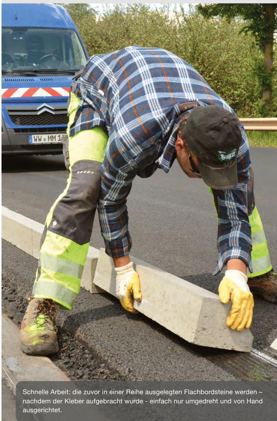
Schnelle Arbeit: die zuvor in einer Reihe ausgelegten Flachbordsteine werden – nachdem der Kleber aufgebracht wurde – einfach nur umgedreht und von Hand ausgerichtet.
