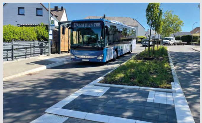
Auf einer Länge von 12 m kam das System Niflux zum Einsatz.
