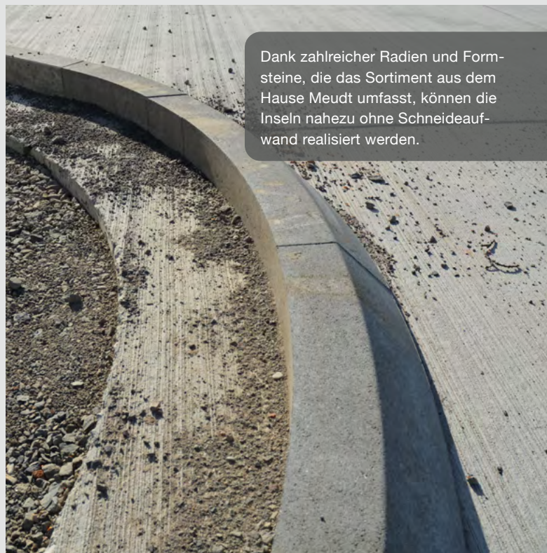
Auch Dehnungsfugen in der Betondecke stellen kein Problem dar. Der Bordstein wird an der Stelle der Fuge einfach geschnitten.
