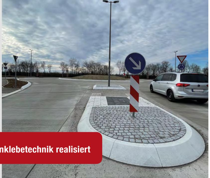
**Kreisverkehr in Poing mit Bordsteinklebetechnik realisiert**
