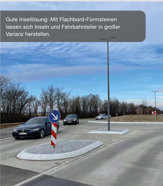
Der Knotenpunkt wurde unter laufendem Verkehr gebaut. Deutlich zu erkennen ist die weiße Reflexinbeschichtung für eine besonders gute Verkehrsleitwirkung – auch bei Dunkelheit.
