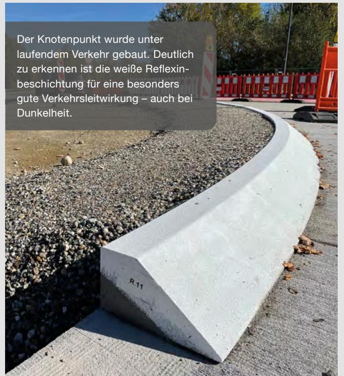
Saubere Lösung: Durch den werkseitigen Schneidprozess werden die sonst üblichen fertigungsbedingten Höhenschwankungen bei den Bordsteinen eliminiert und damit die Steine für die Verklebung sozusagen kalibriert. Maßtoleranzen sind damit nahezu ausgeschlossen.
