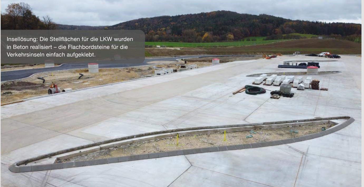
Auch Dehnungsfugen in der Betondecke stellen kein Problem dar. Der Bordstein wird an der Stelle der Fuge einfach geschnitten.
