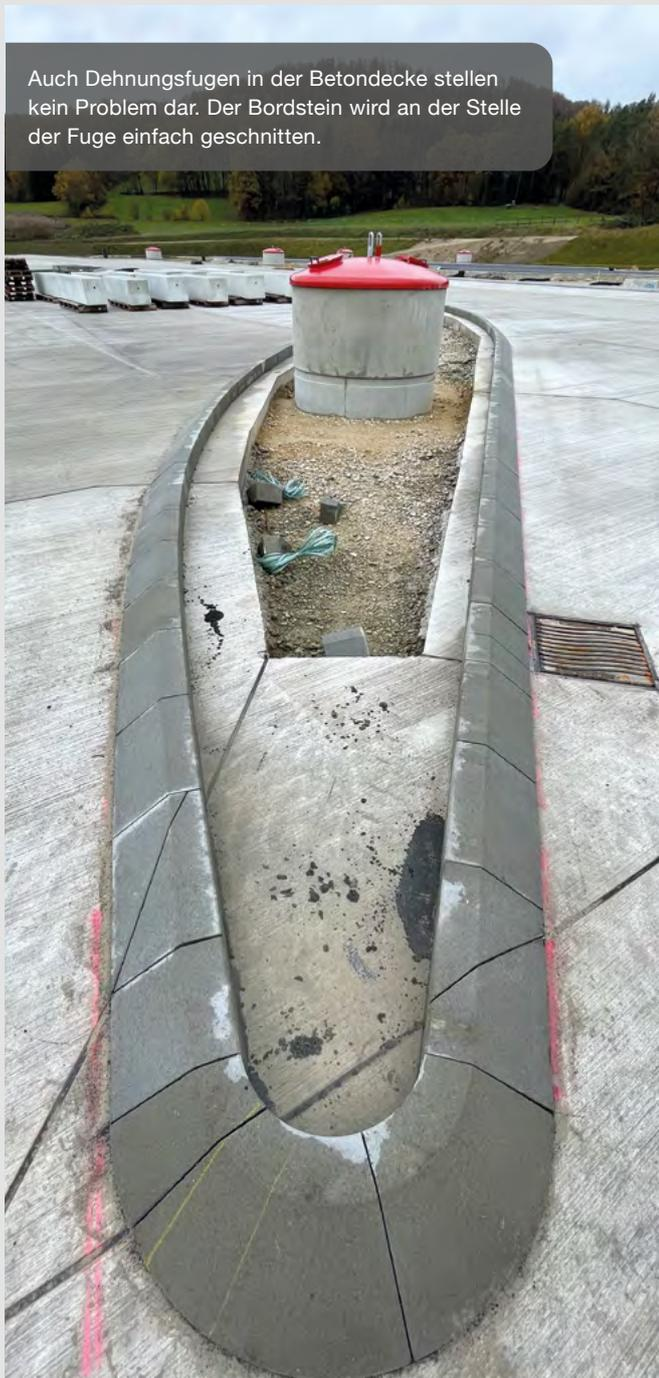
Saubere Lösung: durch Absägen auf eine exakt gleiche Höhe werden fertigungsbedingte Höhen-schwankungen eliminiert.
