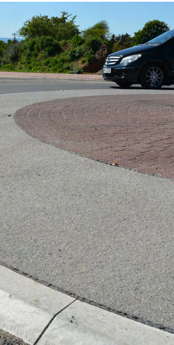
Die Flachbordsteine, die als Randbegrenzung für den Kreisverkehr dienen, wurden unmittelbar auf die vorhandene Asphaltbinder-schicht geklebt. (Foto: Bickhardt Bau AG)
