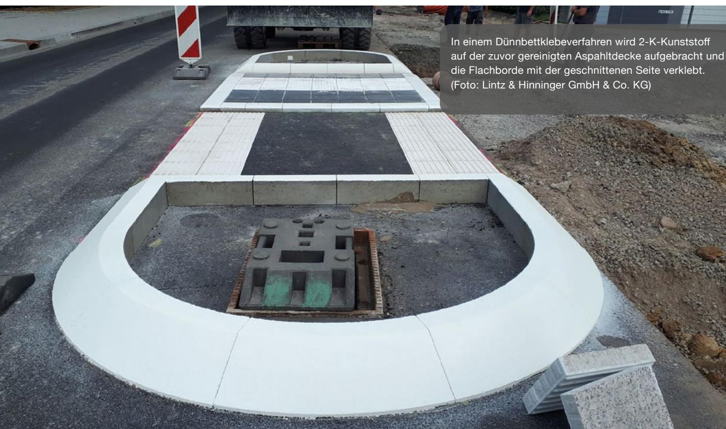
In einem Dünnbettklebverfahren wird 2-K-Kunststoff auf der zuvor gereinigten Asphaltdecke aufgebracht und die Flachborde mit der geschnittenen Seite verklebt. (Foto: Lintz & Hinnerger GmbH & Co. KG)
