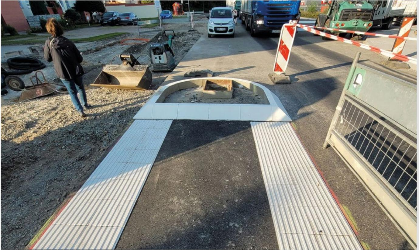
Die Firma Meudt liefert den kompletten Baukasten inkl. Übergangsteine sowie Rippen- und Noppenplatten.
