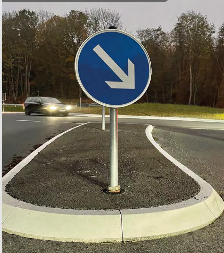
den Schneidprozess entfernt wird. Ein großer Vorteil der Klebetechnik im Vergleich zu konventionell eingebauten Bordsteinen besteht darin, dass die Fahrbahn vorab in einem Schritt durchasphaltiert werden kann – ein mühsames Anarbeiten der Fahrbahn an die gesetzten Borde entfällt hier“, so Helfert.
