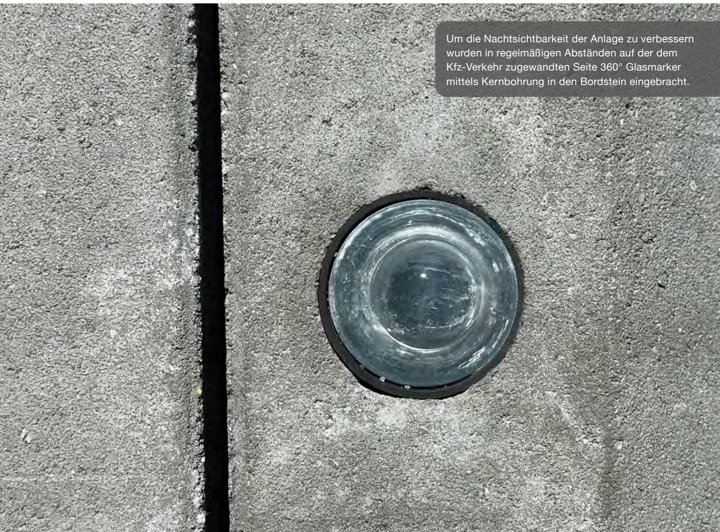
Um die Nachtsichtbarkeit der Anlage zu verbessern wurden in regelmäßigen Abständen auf der dem Kfz-Verkehr zugewandten Seite 360° Glasmarker mittels Kernbohrung in den Bordstein eingebracht.
