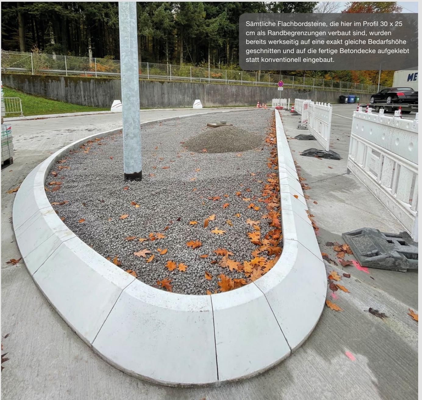
Sämtliche Flachbordsteine, die hier im Profil 30 x 25 cm als Randbegrenzungen verbaut sind, wurden bereits werkseitig auf eine exakt gleiche Bedarfshöhe geschnitten und auf die fertige Betondecke aufgeklebt statt konventionell eingebaut.
