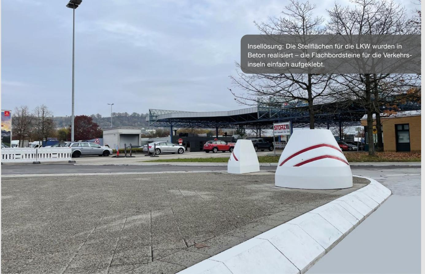
Insellösung: Die Stellflächen für die LKW wurden in Beton realisiert – die Flachbordsteine für die Verkehrsinseln einfach aufgeklebt.
