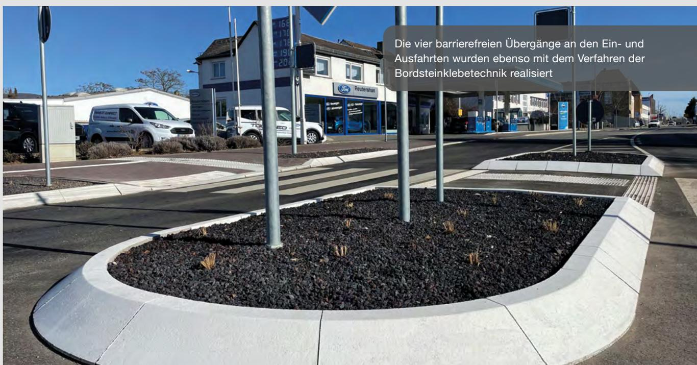
Die vier barrierefreien Übergänge an den Ein- und Ausfahrten wurden ebenso mit dem Verfahren der Bordsteinklebetechnik realisiert
