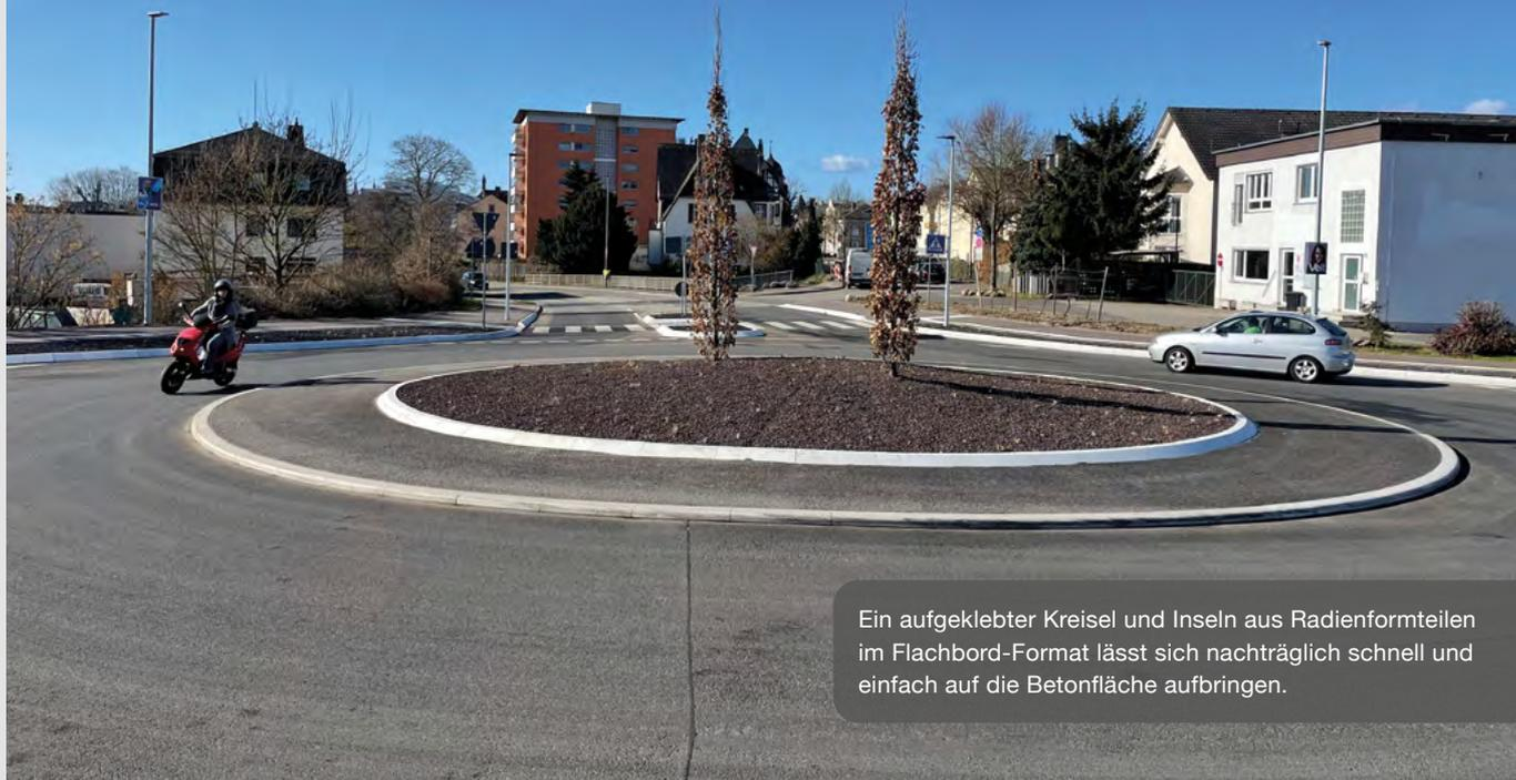
Ein aufgeklebter Kreislauf und Inseln aus Radialformteilen im Flachbrett-Format lässt sich nachträglich schnell und einfach auf die Betonfläche aufbringen.
