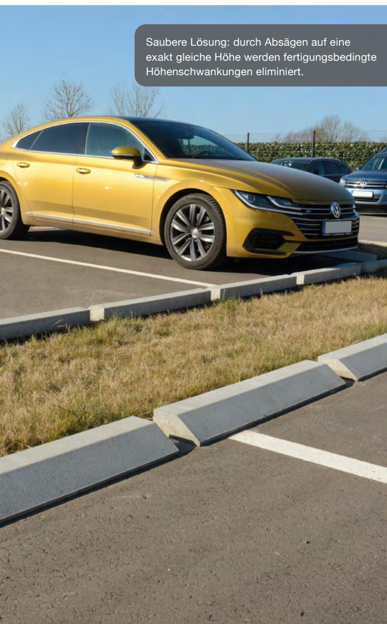
Im Vergleich zur konventionellen Bauweise erfolgte der gesamte Einbau der Flachbordsteine mit der Klebetechnik deutlich sauberer und effizienter.
