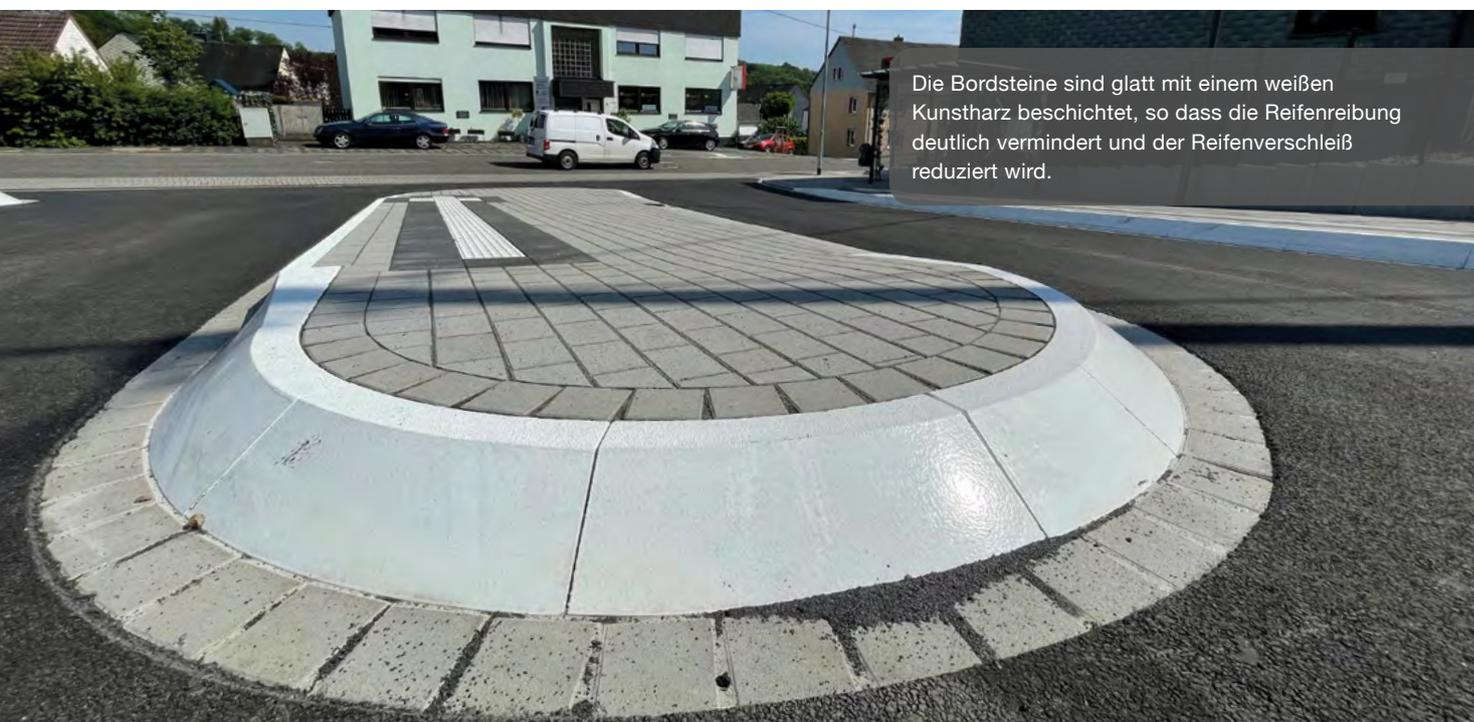
Die Bordsteine sind glatt mit einem weißen Kunstharz beschichtet, so dass die Reifenreibung deutlich vermindert und der Reifenverschleiß reduziert wird.
