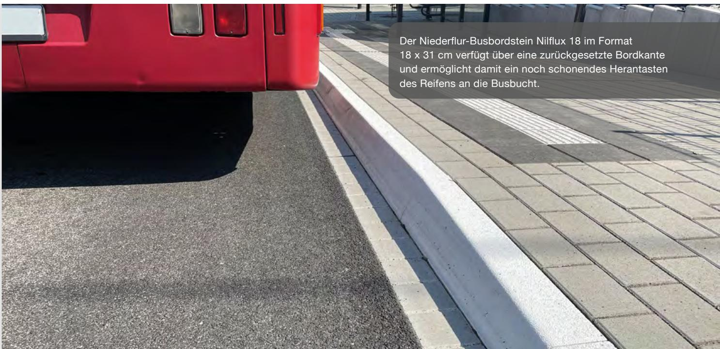
Der Niederflur-Busbordstein Nilflux 18 im Format 18 x 31 cm verfügt über eine zurückgesetzte Bordkante und ermöglicht damit ein noch schonendes Herantasten des Reifens an die Busbucht.
