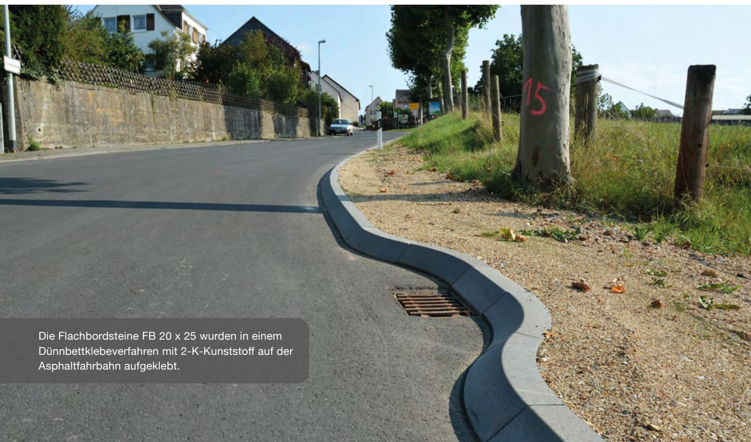
Die Flachbordsteine FB 20 x 25 wurden in einem Dünnbettklebverfahren mit 2-K-Kunststoff auf der Asphaltfahrbahn aufgeklebt.
