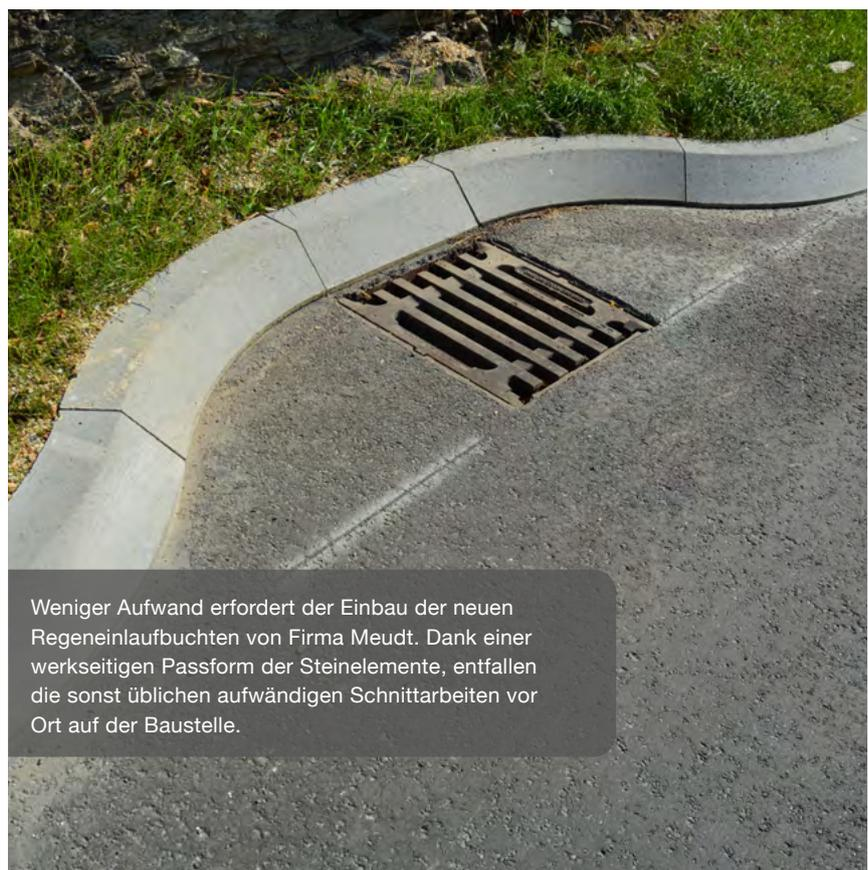
Weniger Aufwand erfordert der Einbau der neuen Regeneinlaufbuchten von Firma Meudt. Dank einer werkseitigen Passform der Steinelemente, entfallen die sonst üblichen aufwändigen Schnitтарbeiten vor Ort auf der Baustelle.
