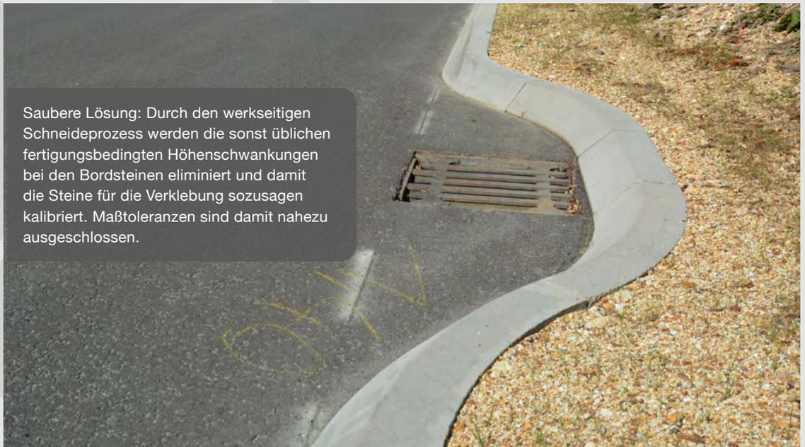
Saubere Lösung: Durch den werkseitigen Schneideprozess werden die sonst üblichen fertigungsbedingten Höhenschwankungen bei den Bordsteinen eliminiert und damit die Steine für die Verklebung sozusagen kalibriert. Maßtoleranzen sind damit nahezu ausgeschlossen.
