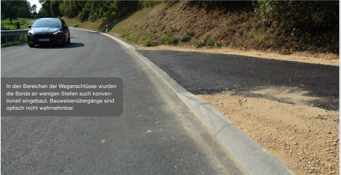
In den Bereichen der Weganschlüsse wurden die Borde an wenigen Stellen auch konventionell eingebaut. Bauweisenübergänge sind optisch nicht wahrnehmbar.
