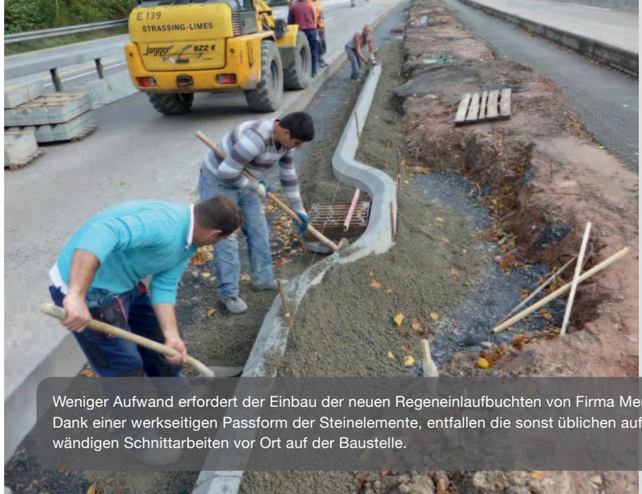
Weniger Aufwand erfordert der Einbau der neuen Regeneinlaufbuchten von Firma Meudt. Dank einer werkseitigen Passform der Steinelemente, entfallen die sonst üblichen aufwändigen Schnitarbeiten vor Ort auf der Baustelle.
