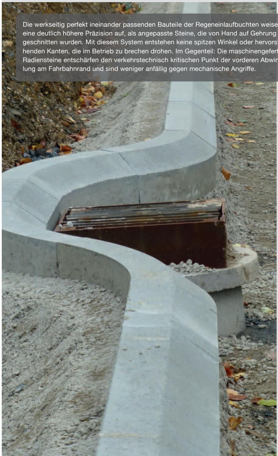
Die werkseitig perfekt ineinander passenden Bauteile der Regeneinlaufbuchten weisen eine deutlich höhere Präzision auf, als angepasste Steine, die von Hand auf Gehrung geschnitten wurden. Mit diesem System entstehen keine spitzen Winkel oder hervorstehenden Kanten, die im Betrieb zu brechen drohen. Im Gegenteil: Die maschinengefertigten Radensteine entschärfen den verkehrstechnisch kritischen Punkt der vorderen Abwinklung am Fahrbahnrand und sind weniger anfällig gegen mechanische Angriffe.
