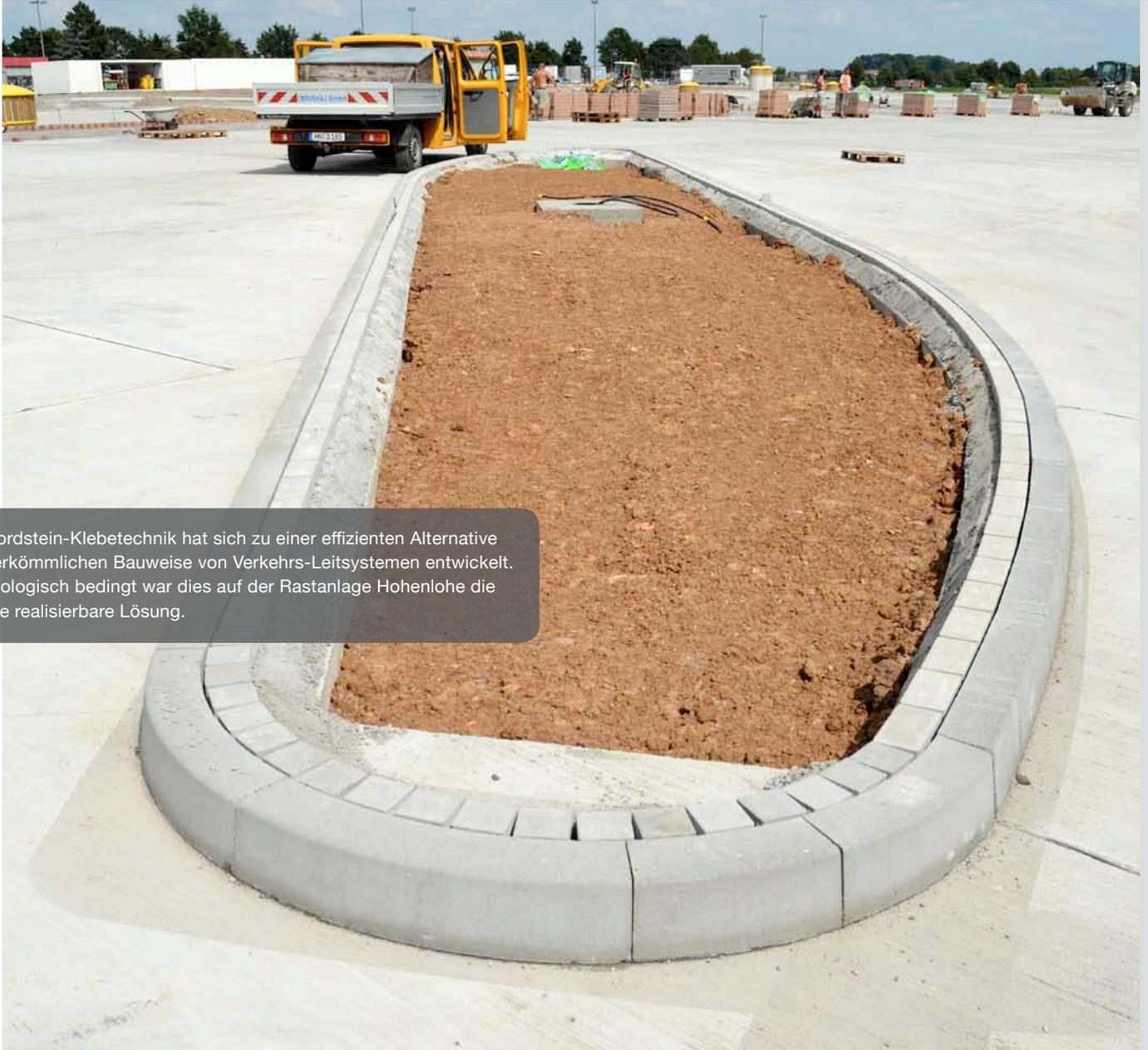
Die Bordstein-Klebetchnik hat sich zu einer effizienten Alternative zur herkömmlichen Bauweise von Verkehrs-Leitsystemen entwickelt. Technologisch bedingt war dies auf der Rastanlage Hohenlohe die einzige realisierbare Lösung.
