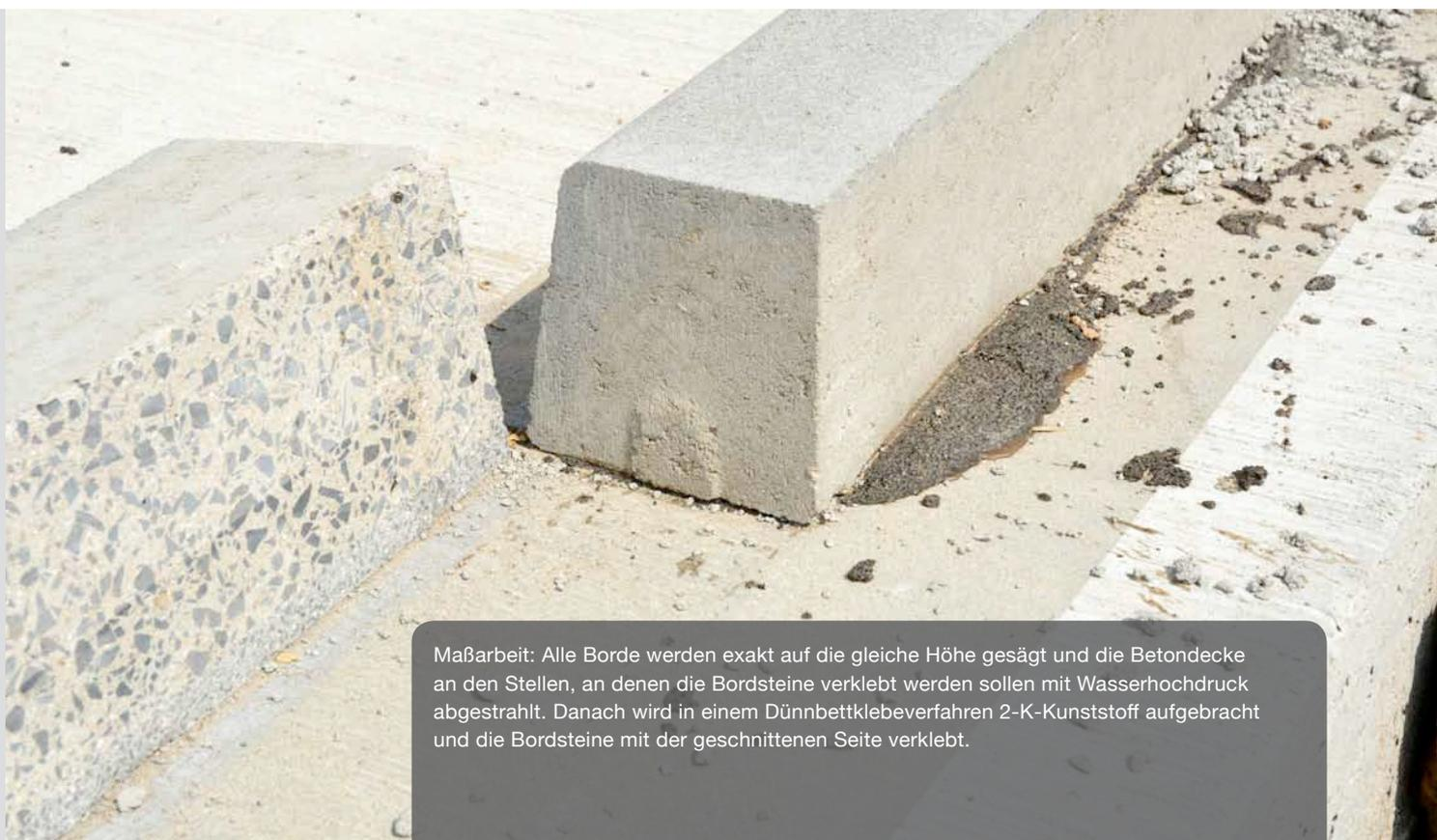
Maßarbeit: Alle Borde werden exakt auf die gleiche Höhe gesägt und die Betondecke an den Stellen, an denen die Bordsteine verklebt werden sollen mit Wasserhochdruck abgestrahlt. Danach wird in einem Dünnbettklebeverfahren 2-K-Kunststoff aufgebracht und die Bordsteine mit der geschnittenen Seite verklebt.
