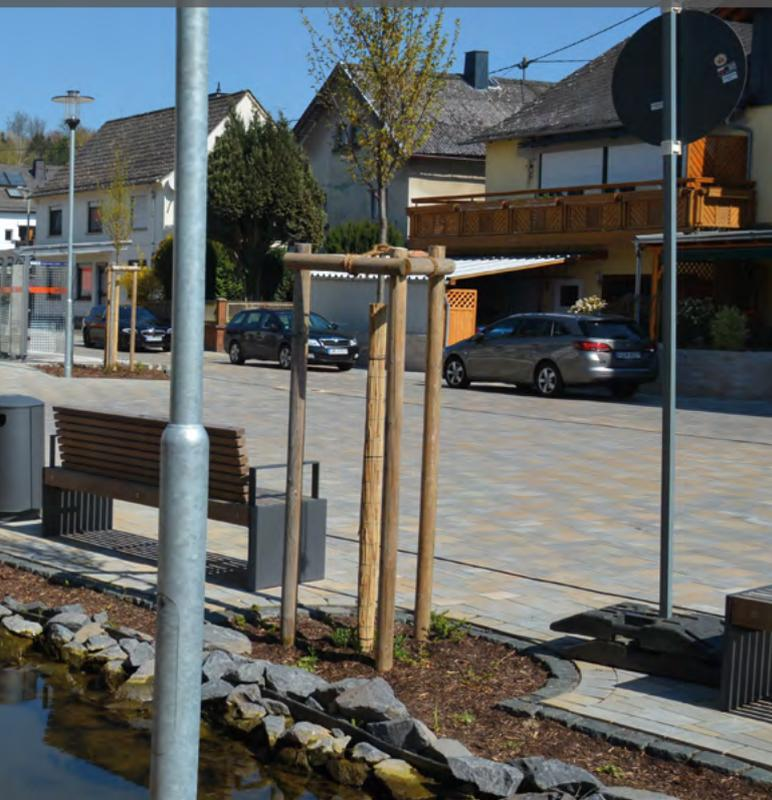
Die Fahrbahn vor dem Eingang des Bürgerhauses wurde mit dem 14 cm dicken Ideal-Pflaster befestigt. (Foto: Hermann MEUDT Betonsteinwerk GmbH)
