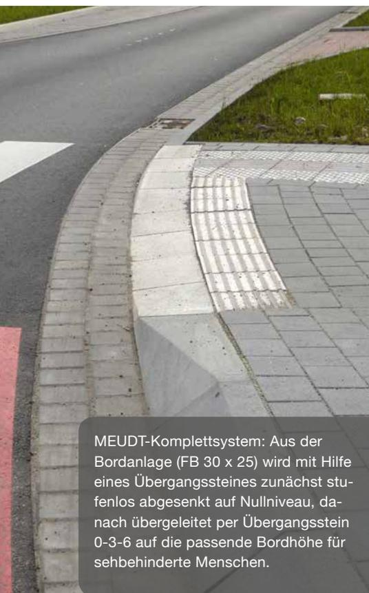
MEUDT-Komplettsystem: Aus der Bordanlage (FB 30 x 25) wird mit Hilfe eines Übergangsteines zunächst stufenlos abgesenkt auf Nullniveau, danach übergeleitet per Übergangstein 0-3-6 auf die passende Bordhöhe für sehbehinderte Menschen.
