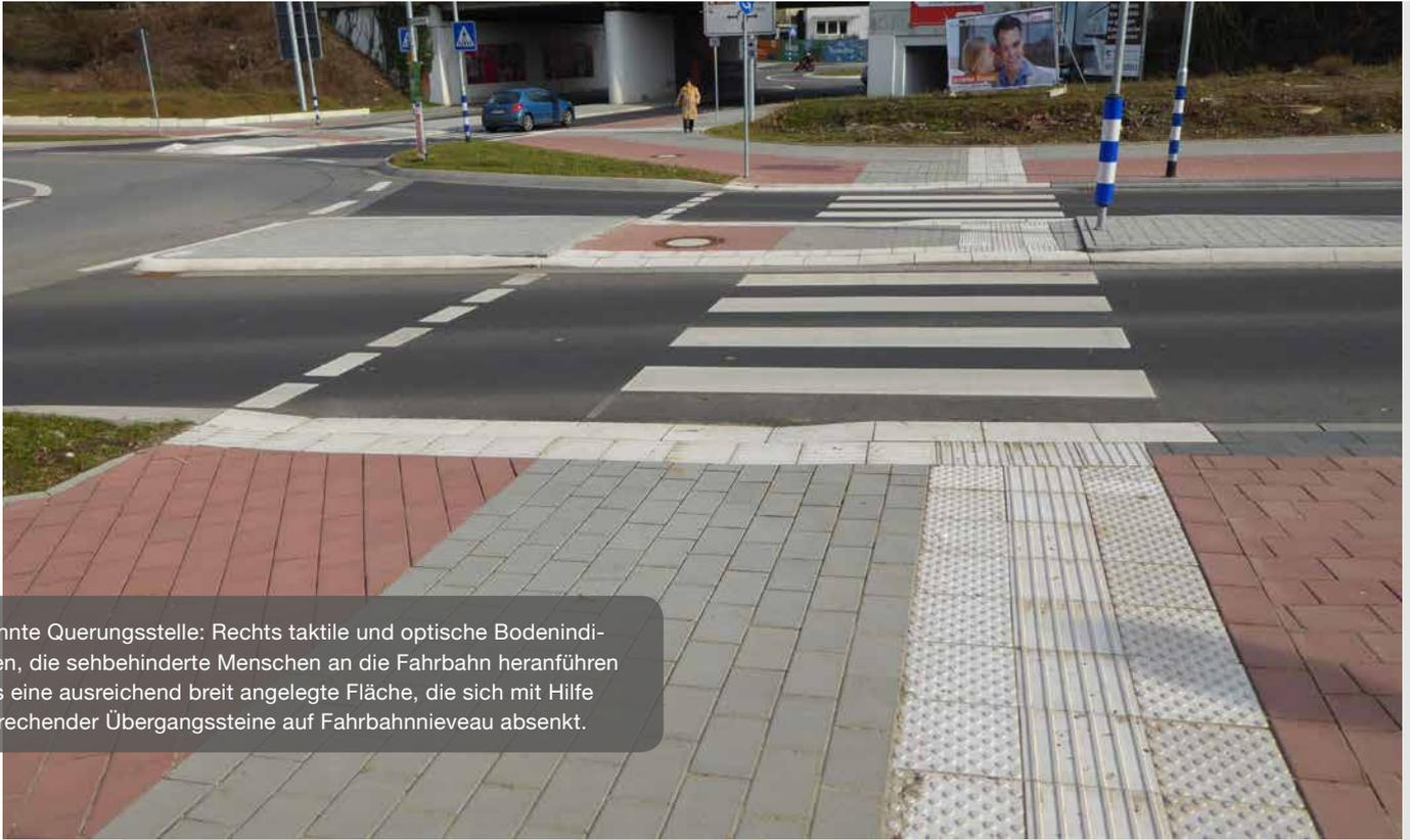
Getrennte Querungsstelle: Rechts taktile und optische Bodenindikatoren, die sehbehinderte Menschen an die Fahrbahn heranführen – links eine ausreichend breit angelegte Fläche, die sich mit Hilfe entsprechender Übergangsteine auf Fahrbahnniveau absenkt.
