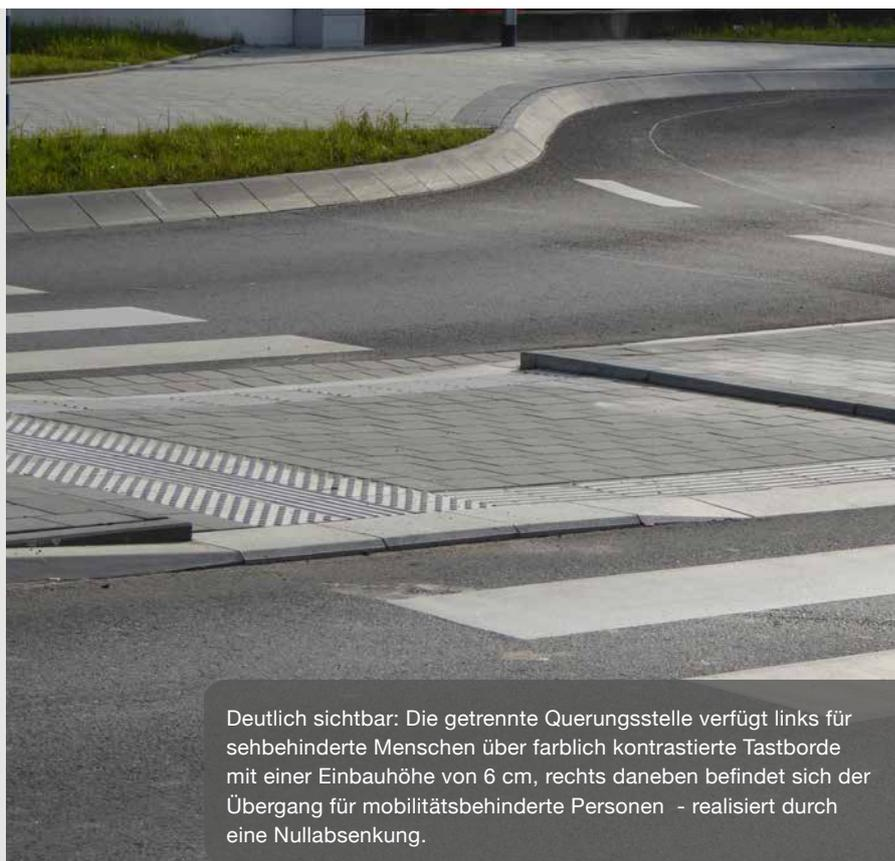
Deutlich sichtbar: Die getrennte Querungsstelle verfügt links für sehbehinderte Menschen über farblich kontrastierte Tastborde mit einer Einbauhöhe von 6 cm, rechts daneben befindet sich der Übergang für mobilitätsbehinderte Personen - realisiert durch eine Nullabsenkung.
