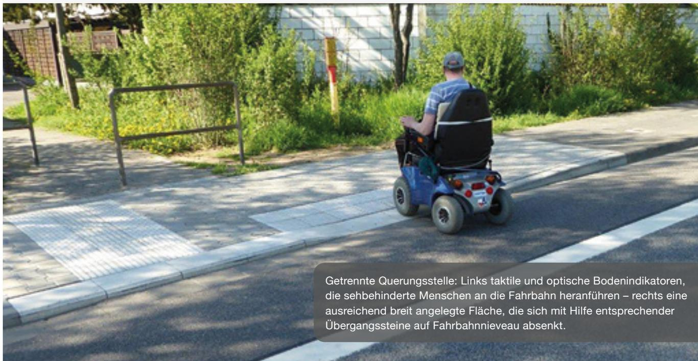
Getrennte Querungsstelle: Links taktile und optische Bodenindikatoren, die sehbehinderte Menschen an die Fahrbahn heranführen – rechts eine ausreichend breit angelegte Fläche, die sich mit Hilfe entsprechender Übergangsteine auf Fahrbahnniveau absenkt.
