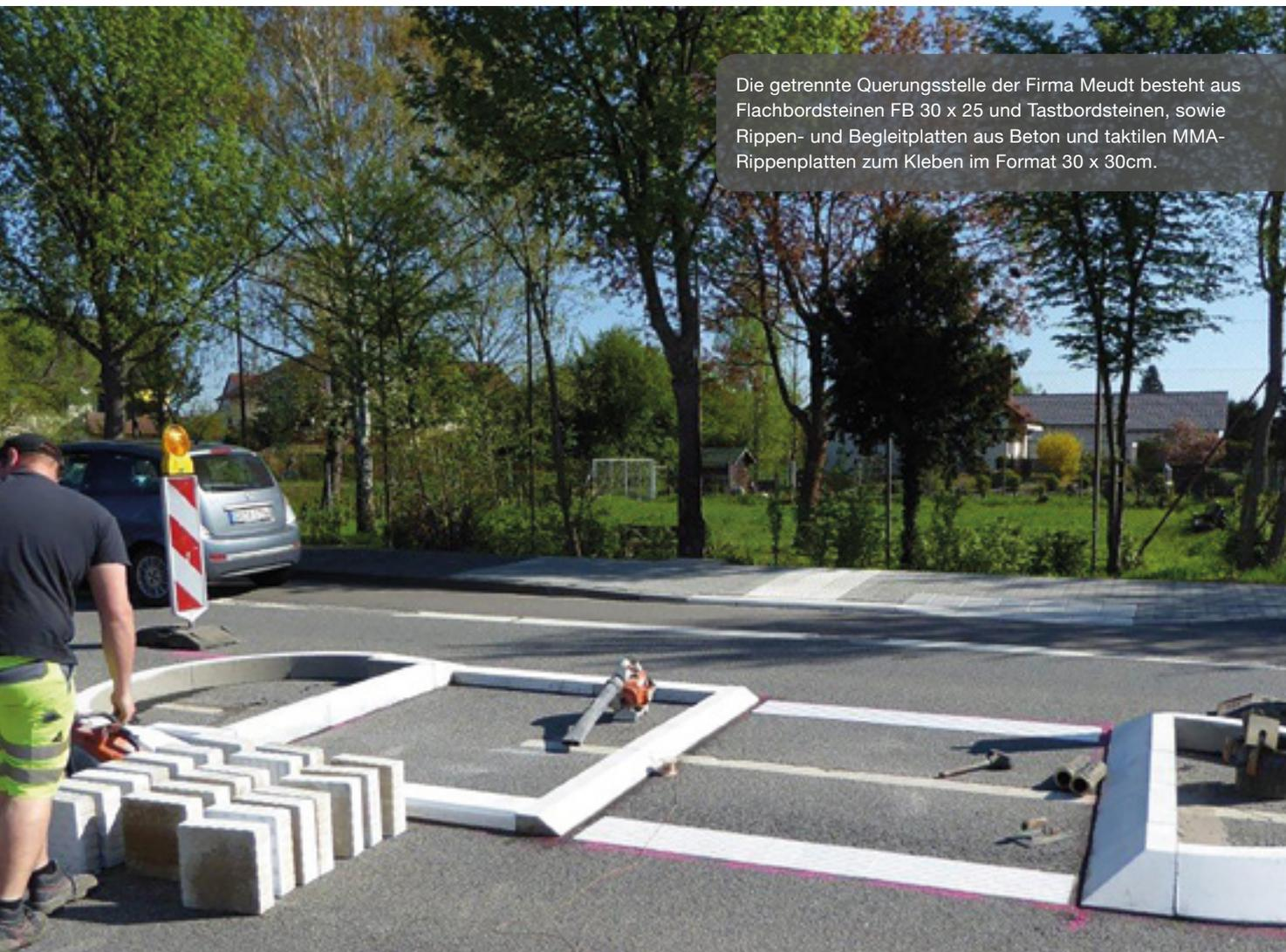
Die getrennte Querungsstelle der Firma Meudt besteht aus Flachbordsteinen FB 30 x 25 und Tastbordsteinen, sowie Rippen- und Begleitplatten aus Beton und taktilen MMA-Rippenplatten zum Kleben im Format 30 x 30cm.
