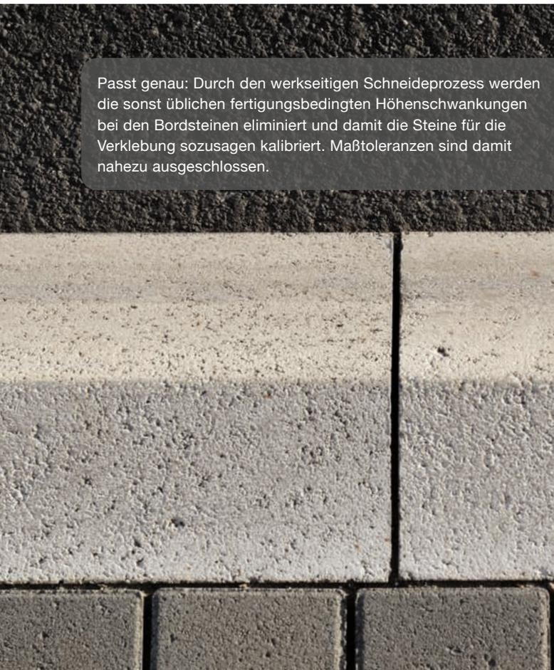
Passt genau: Durch den werkseitigen Schneideprozess werden die sonst üblichen fertigungsbedingten Höhenschwankungen bei den Bordsteinen eliminiert und damit die Steine für die Verklebung sozusagen kalibriert. Maßtoleranzen sind damit nahezu ausgeschlossen.
