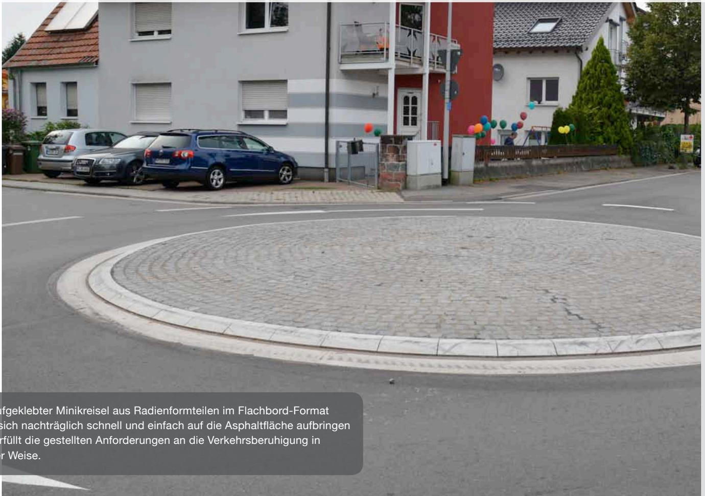
Ein aufgeklebter Minikreisel aus Radienformteilen im Flachbord-Format lässt sich nachträglich schnell und einfach auf die Asphaltfläche aufbringen und erfüllt die gestellten Anforderungen an die Verkehrsberuhigung in idealer Weise.
