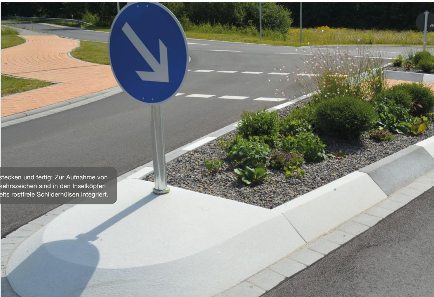
Einstecken und fertig: Zur Aufnahme von Verkehrszeichen sind in den Inseköpfen bereits rostfreie Schilderhülsen integriert.
