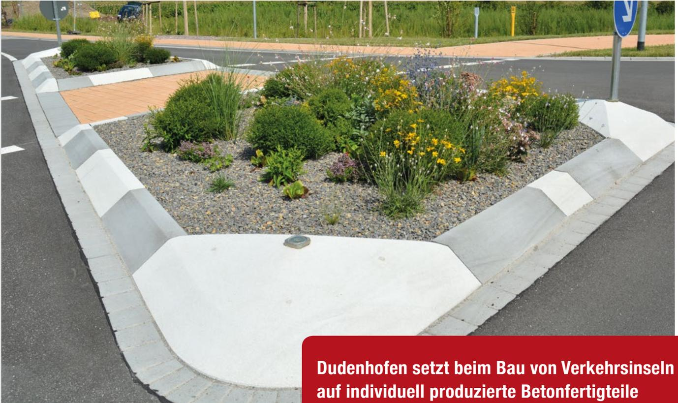
**Dudenhofen setzt beim Bau von Verkehrsinseln auf individuell produzierte Betonfertigteile**
