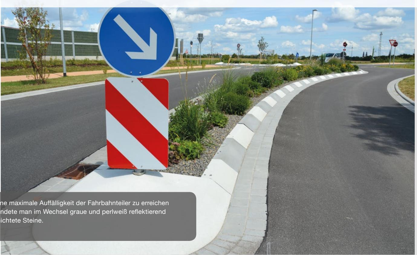
Um eine maximale Auffälligkeit der Fahrbahnteiler zu erreichen verwendete man im Wechsel graue und perlweiß reflektierend beschichtete Steine.
