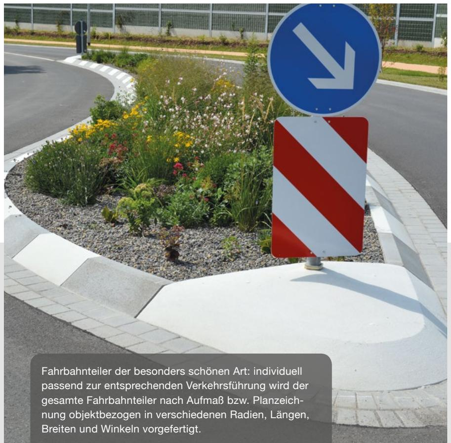
Fahrbahnteiler der besonders schönen Art: individuell passend zur entsprechenden Verkehrsführung wird der gesamte Fahrbahnteiler nach Aufmaß bzw. Planzeichnung objektbezogen in verschiedenen Radien, Längen, Breiten und Winkeln vorgefertigt.
