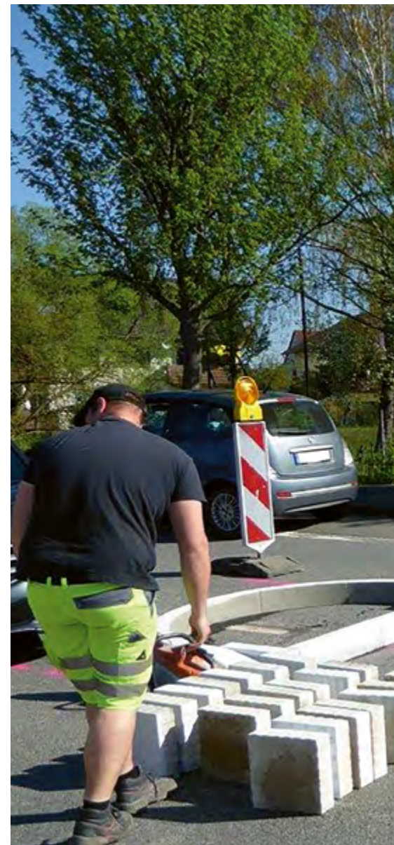
Getrennte Querungsstelle: Links taktile und optische Bodenindikatoren, die sehbehinderte Menschen an die Fahrbahn heranführen – rechts eine ausreichend breit angelegte Fläche, die sich mit Hilfe entsprechender Übergangsteine auf Straßenniveau absenkt.
