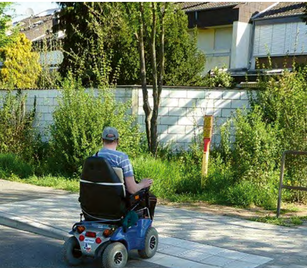
Getrennte Querungsstelle: Links taktile und optische Bodenindikatoren, die sehbehinderte Menschen an die Fahrbahn heranführen – rechts eine ausreichend breit angelegte Fläche, die sich mit Hilfe entsprechender Übergangsteine auf Straßenniveau absenkt.
